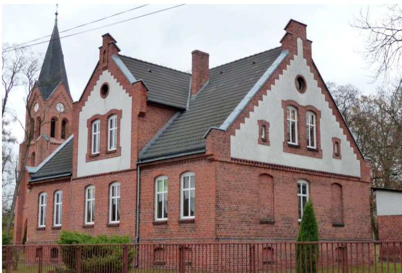
Widok budynku od południowego-zachodu
