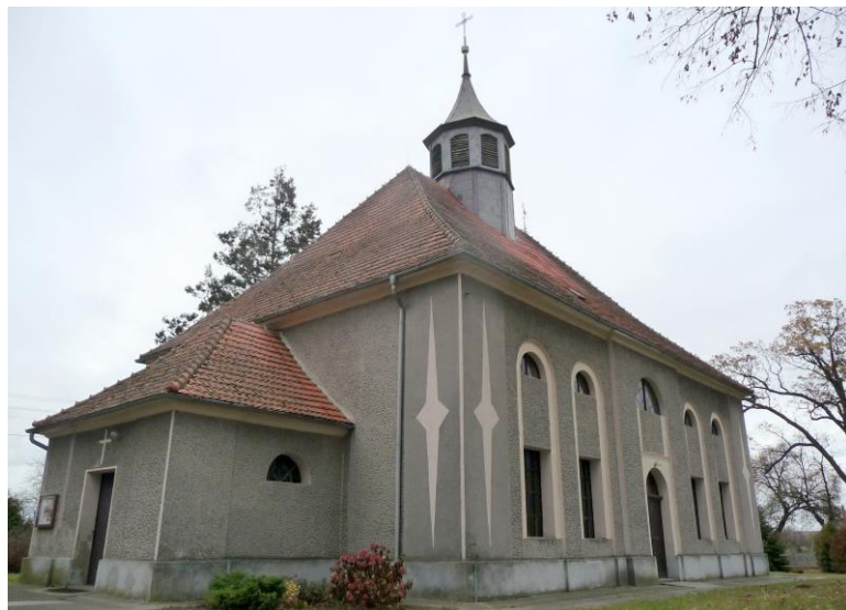
Widok od południowego-zachodu
