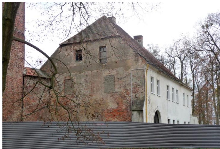
Widok budynku od północnego-zachodu
