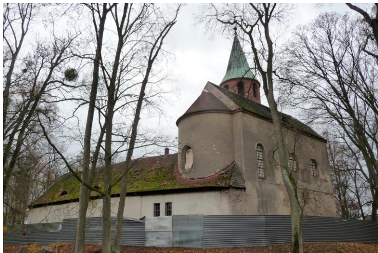
Widok budynku od północnego-wschodu
