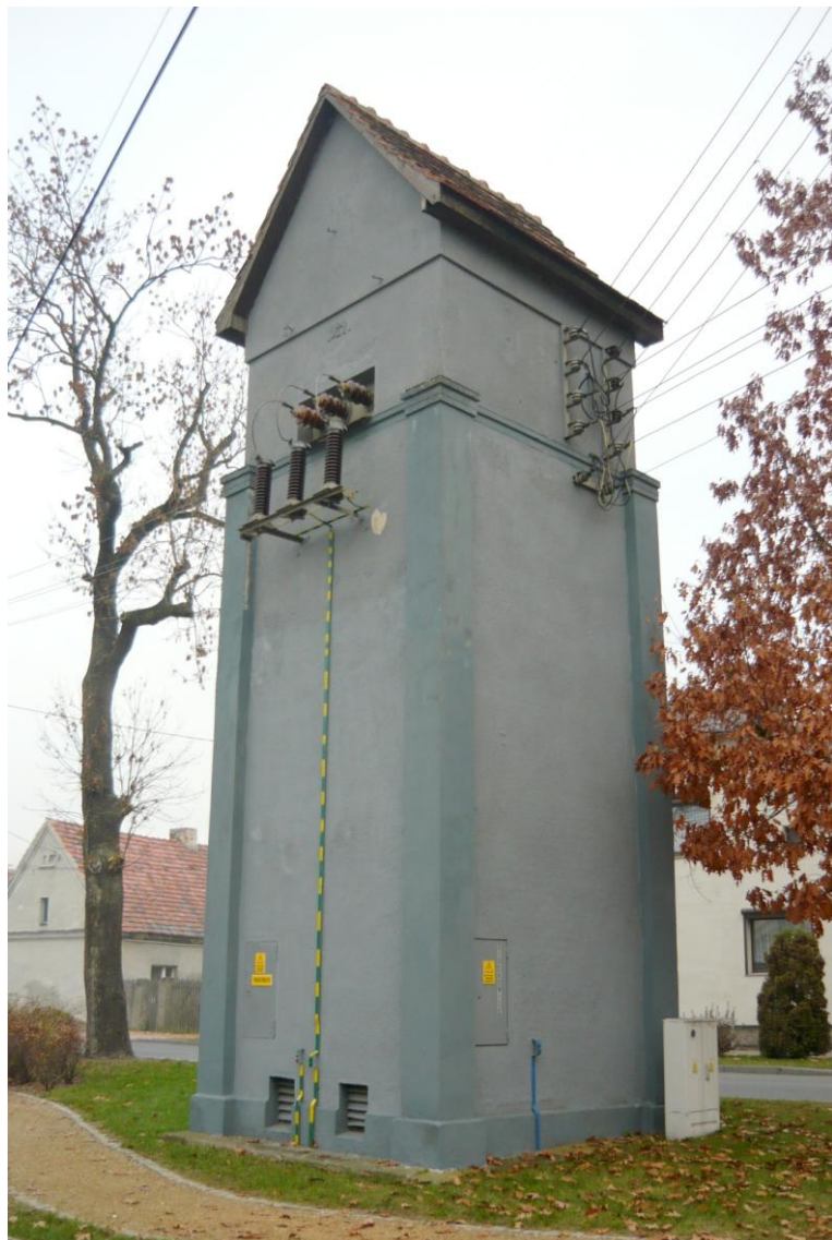
Widok od południowego-zachodu
