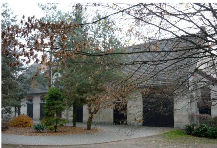
Widok budynku od północy
