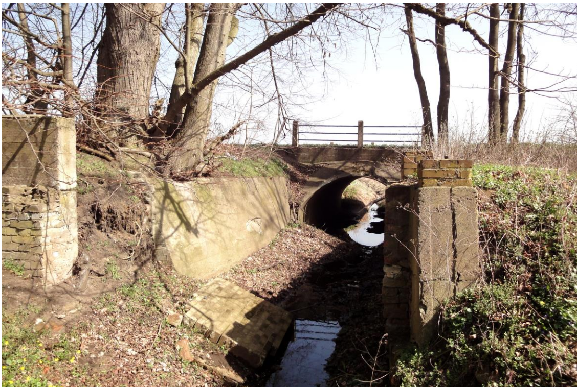
Widok od południowego-zachodu
