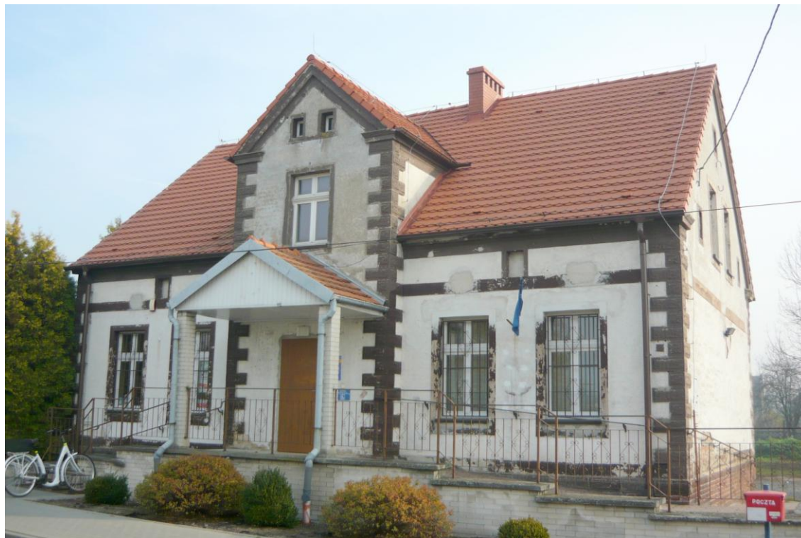
Widok budynku od północnego-zachodu
