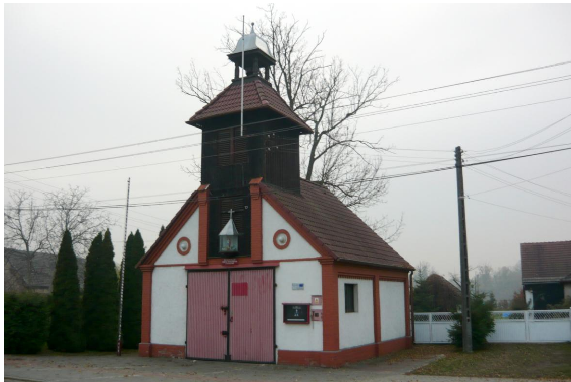
Widok budynku od północy
