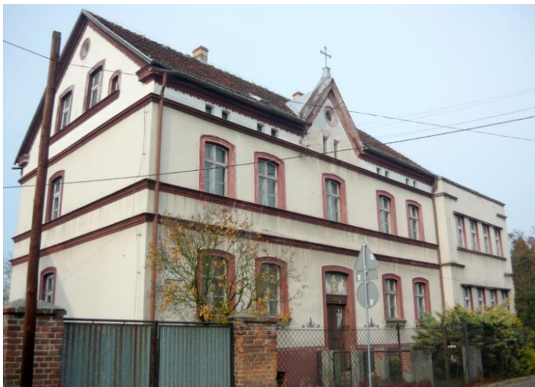
Widok budynku od południa
