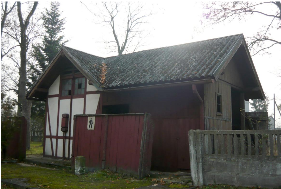
Widok budynku od północnego-wschodu
