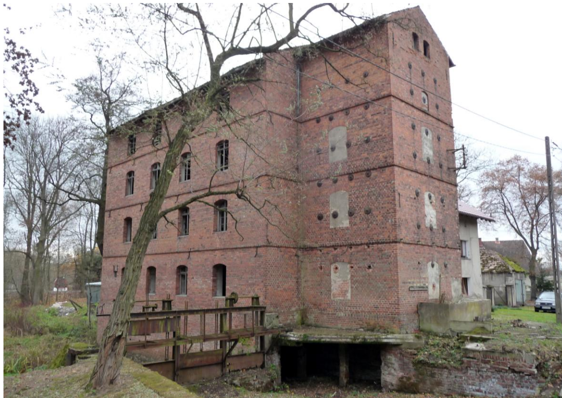
Widok budynku od północnego-wschodu
