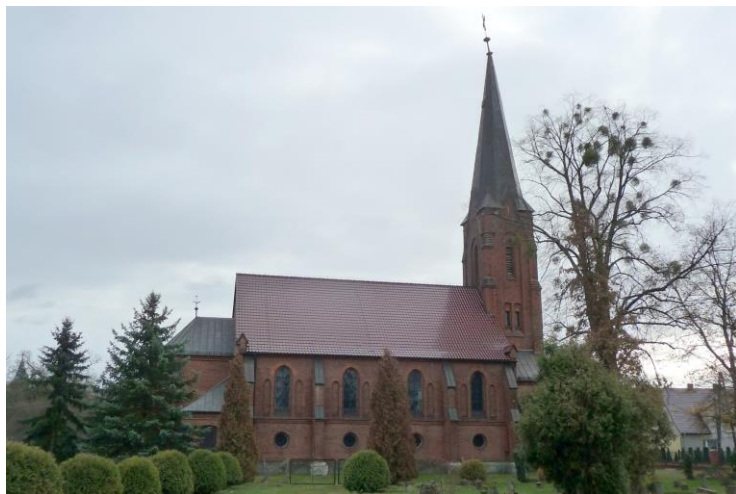
Widok od północnego-zachodu
