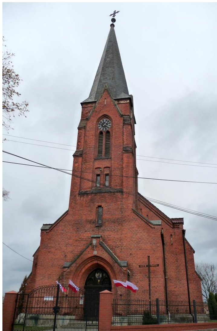
Widok od południowego-zachodu
