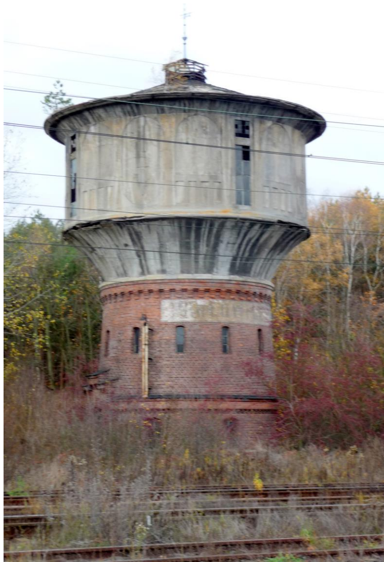
Widok budynku od wschodu
